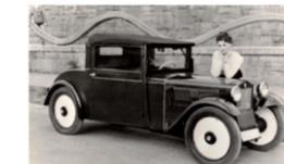
1931 DKW F1 mit Zweitaktmotor und Frontantrieb
